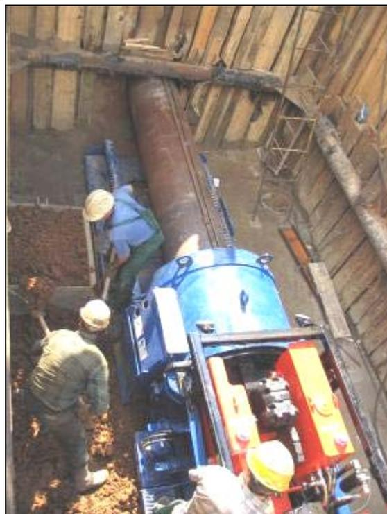
*Рис. 4. Установка «American Augers» в рабочем котловане*
