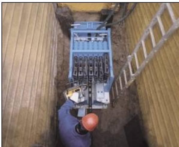
Рис. 3. Работа установки Grundoburst с магазином для штанг
