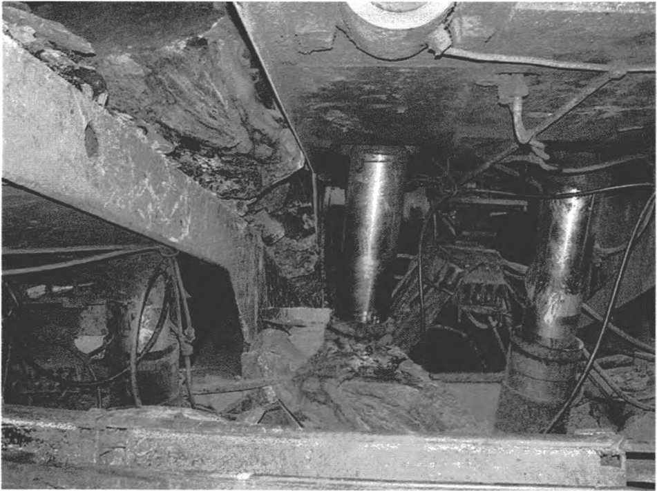
Рис. 5. Зажатие секции механизированной крепи
