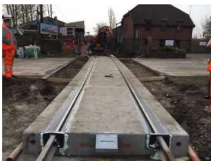
Рис.2. Весы на сборном железобетоне.
