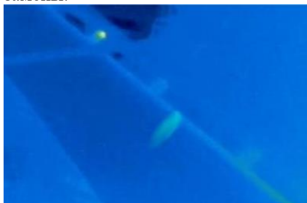
Рис. 13. Тепловой след нагретого ролика на конвейерной ленте
