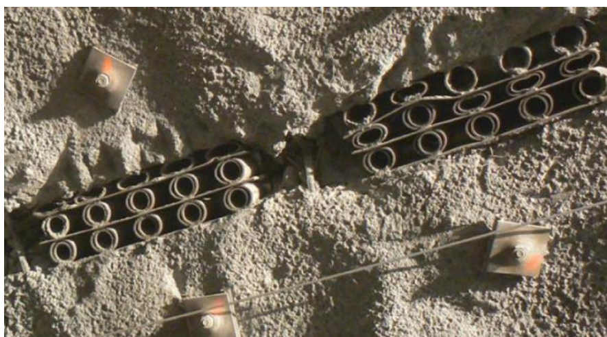
Рисунок 2. Применение WABE элементов для соединения тубингов [4]
